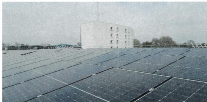
Ce projet a permis de refaire a neuf l'étanchéité et l'isolation des 2300 m<sup>2</sup> de toitures concernées par la solarisation. La résistance thermique des toitures a été triplés (passage d'une résistance thermique de 1.5 à une résistance thermique de 4,5) et le projet a également permis de sécurisé les accès aux toitures.
