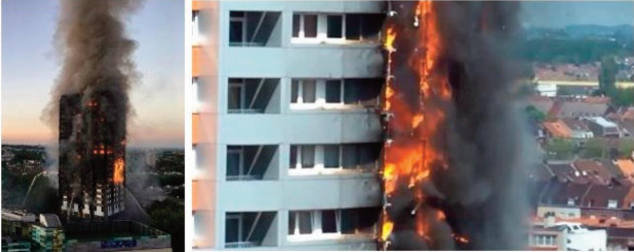
Ce type de feu est dévastateur, car il se développe très vite le long des parois extérieures des bâtiments, en enflammant tout ce qu'il trouve sur son passage. Il se nourrit des matériaux composant les façades (bois, isolant) et de tout potentiel calorifique croisant son passage (cadres de fenêtres, mobiliers ou accessoires entreposés sur les balcons...). Ainsi, il rentre et s'installe dans les appartements, détruit tout, et poursuit sa course.
