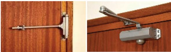
La mise en place d'un ferme-porte sur une porte de logement (y compris dépourvue de qualité de résistance au feu) contribue efficacement à l'étanchéité de ce dernier en cas d'incendie. L'avantage est double en cas d'abandon du logement suite à évacuation : le volume ne sera pas consommé par un incendie extérieur au logement et réciproquement, un incendie né dans le logement ne se propagera pas vers la cage d'escalier.
