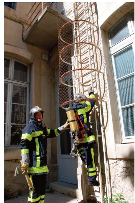
Des échelles fixes ou débrayables courant le long d'une façade difficile d'accès ou hors d'atteinte des secours peuvent être mises en place pour rejoindre le rez-de-chaussée ou une zone sûre
