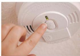
Vérifiez périodiquement leur bon fonctionnement (bouton « test »). Dépoussiérez-les régulièrement. Si elles ne sont pas au lithium, remplacez les piles une fois / an (au passage à l'heure d'hiver par exemple).
